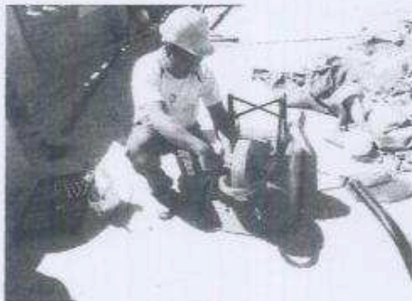
Albañiles trabajando en el proceso de liberación de materiales impermeabilizantes de la azotea del Torreón Central.
