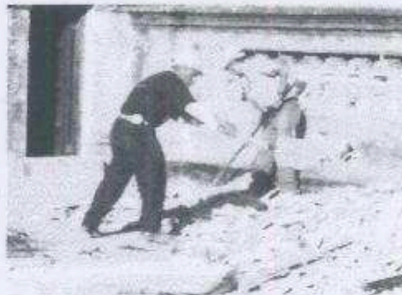
Albañiles trabajando en el proceso de liberación de materiales impermeabilizantes de la azotea del Torreón Central.
